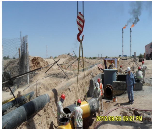
伊拉克布祖尔干油田管线升级EPC 项、大罐清洗维修项目
