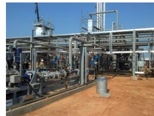
天然气处理场站
