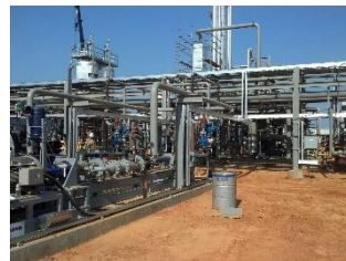
天然气处理场站
