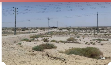
Dhufriyah油田开发项目 25年
