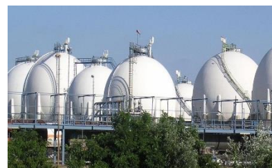
天然气储存设施
